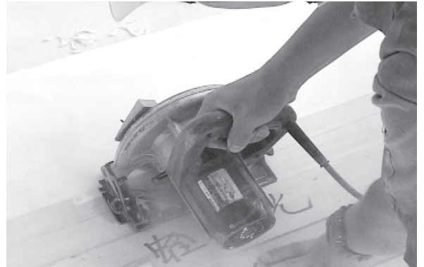
現場での切断作業
